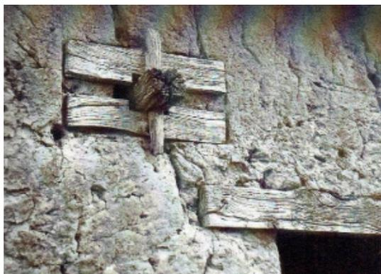
Рис. 18. Деревянная тяга способствует устойчивости конструкции. *Источник: В. Pignal, 2005*
