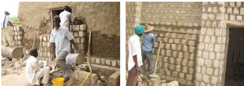
Рис. 10. Гибридная стена (земля и камень)
