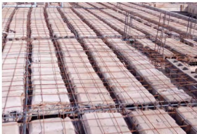
Рис. 12. Крыша перед заливкой бетона
