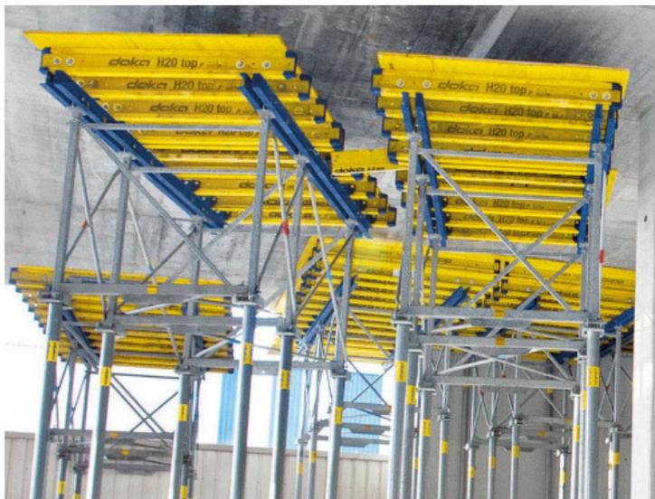
Рис. 3. Пример использования стола Dokamatic
